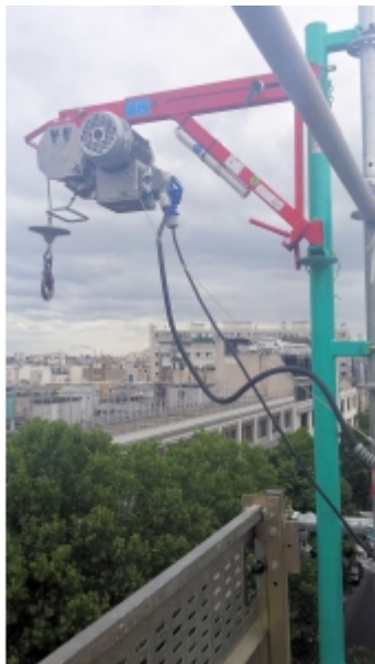
Installation avec un étau d'échafaudage
