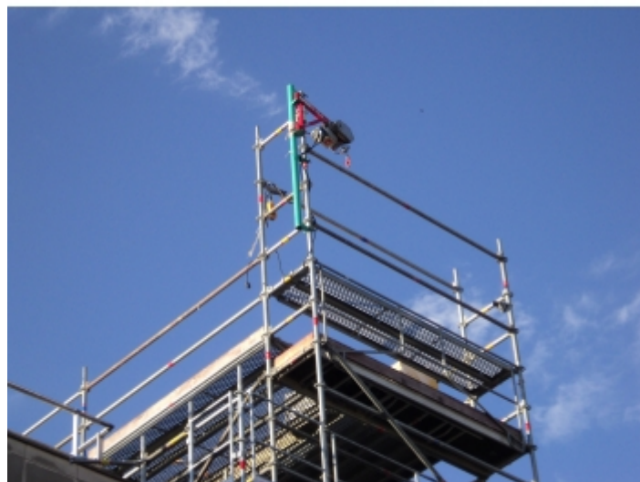
Installation avec un étai d'échafaudage
