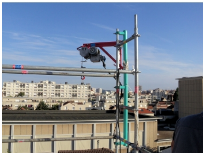
Installation avec un étau d'échafaudage
