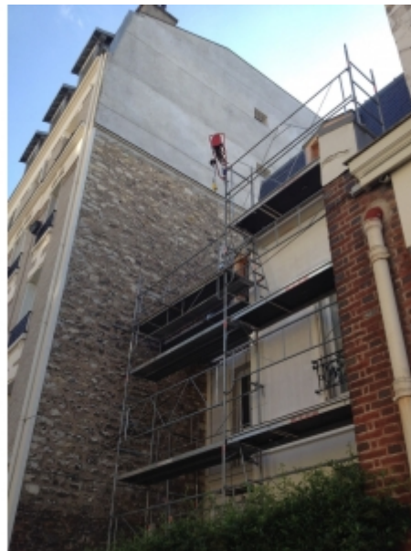
Installation sur échafaudage
