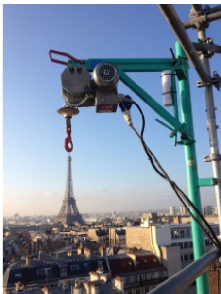
Installation avec un étau d'échafaudage
