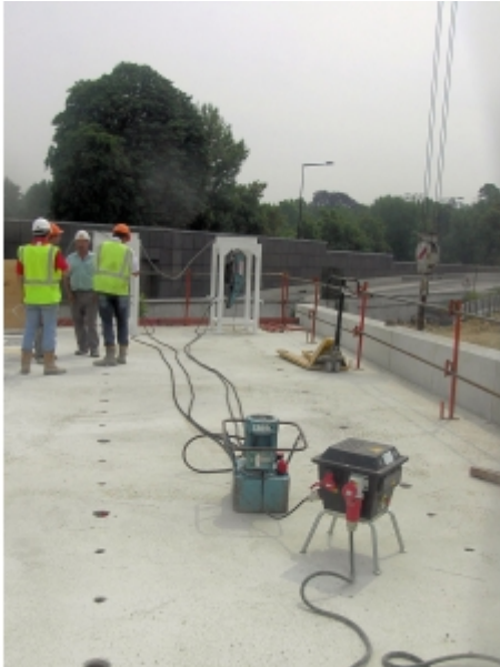
Installation sur chantier
