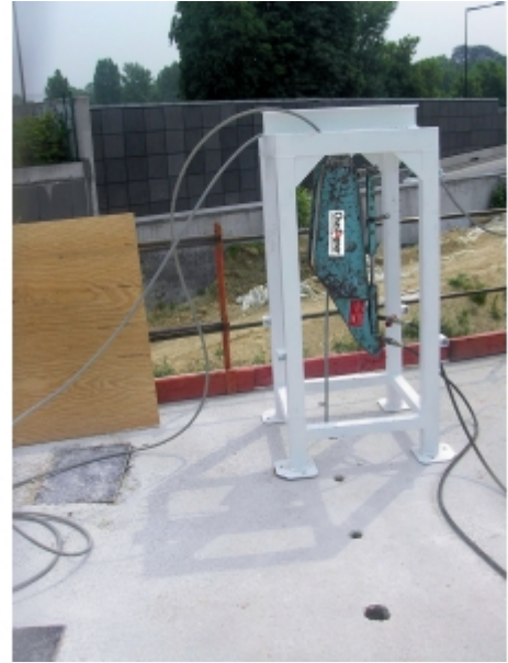
Installation sur chantier
