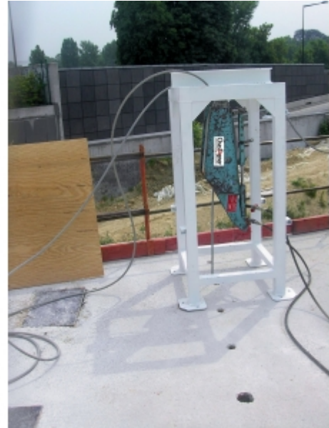
Installation sur chantier
