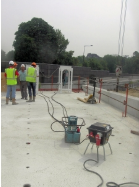
Installation sur chantier
