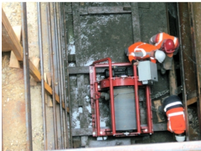
Travaux de réseaux
