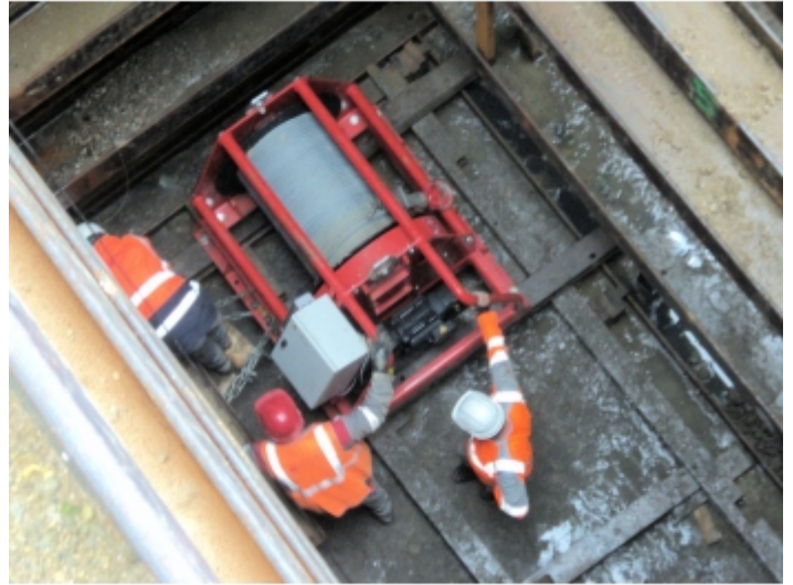
Travaux de réseaux
