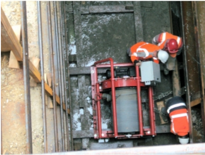
Travaux de réseaux
