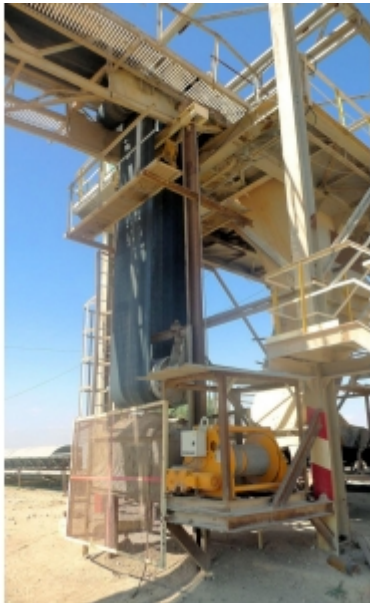
Installation en carrières
