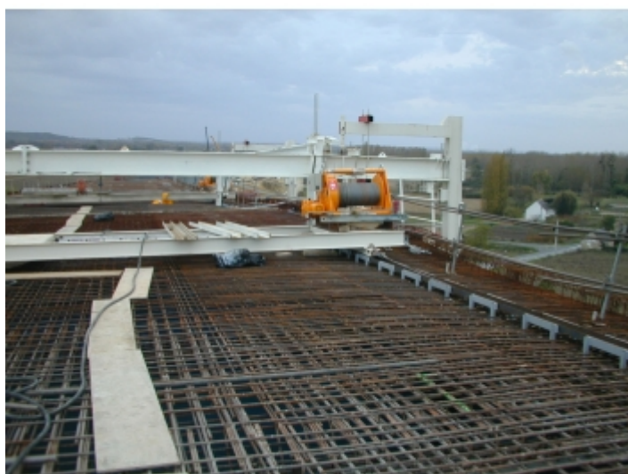
Installation sur un ouvrage d'art
