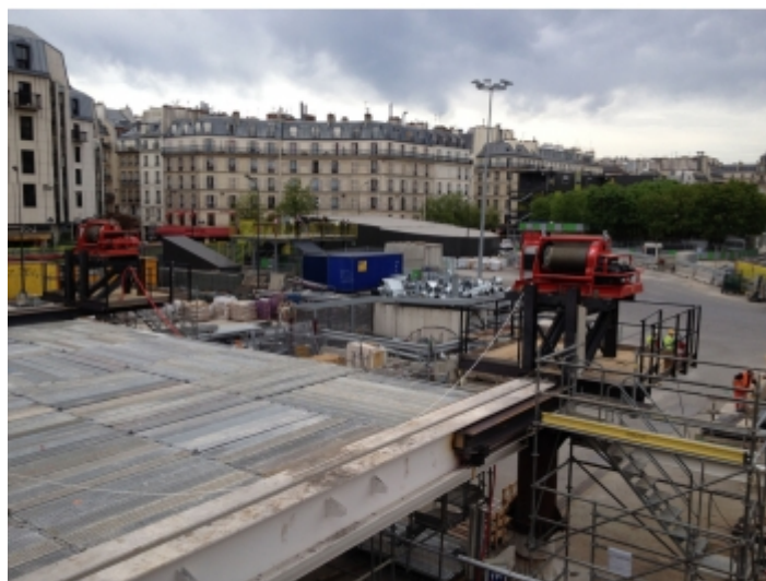
Installation pour la construction d'un immeuble
