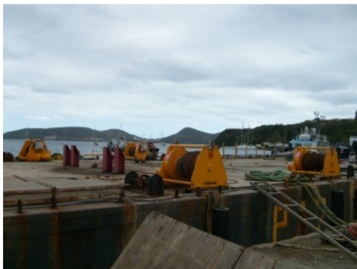
Installation sur un port maritime
