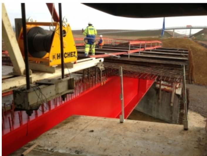
Installation sur un ouvrage d'art
