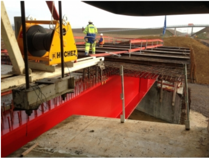
Installation sur un ouvrage d'art
