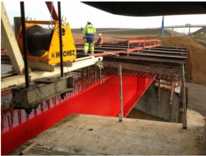
Installation sur un ouvrage d'art
