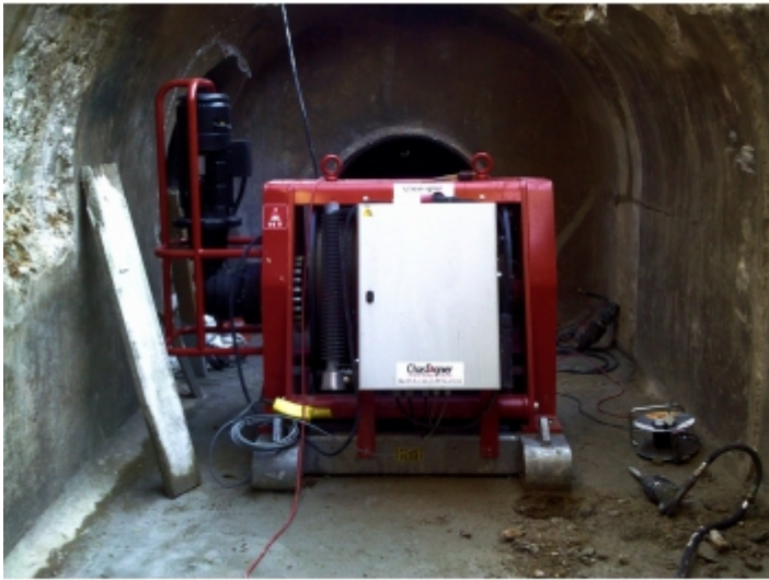
Travaux de réseaux
