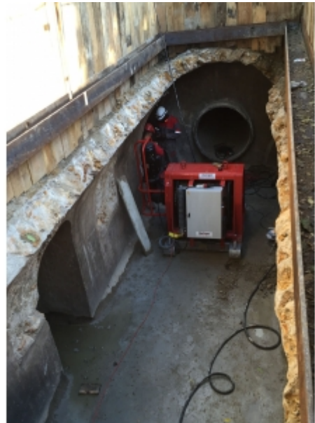
Travaux de réseaux
