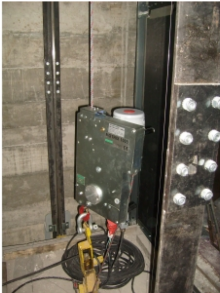
Installation dans une trémie d'ascenseur
