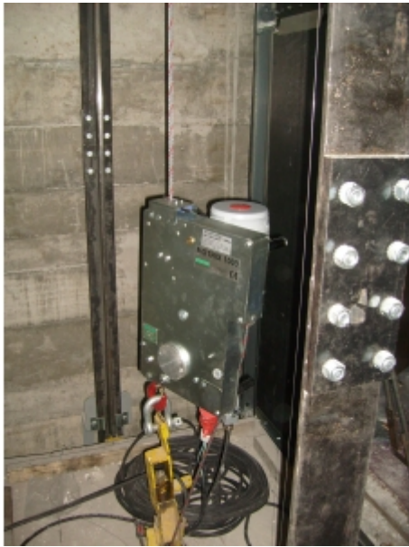
Installation dans une trémie d'ascenseur
