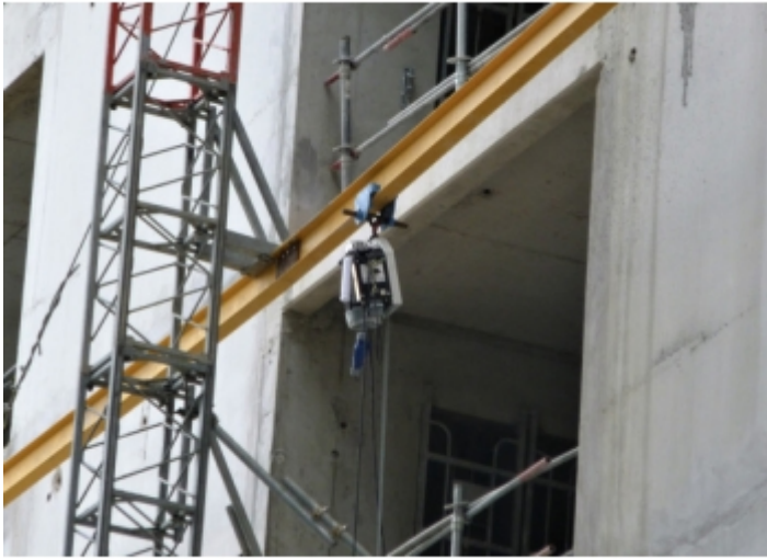
Le treuil électrique à chaîne chastagner location sur un chantier
