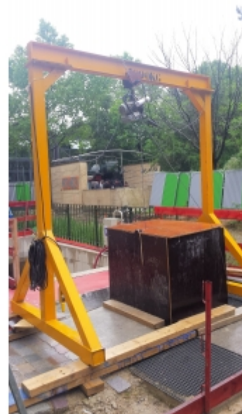
Installation sur portique
