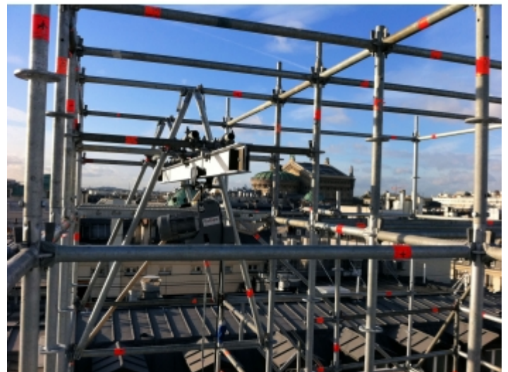
Installation sur fer fixée sur échafaudage
