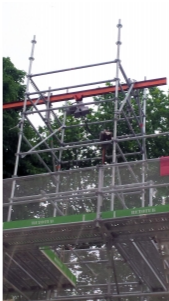
Installation sur fer fixée sur échafaudage
