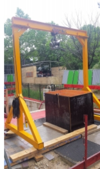
Installation sur portique
