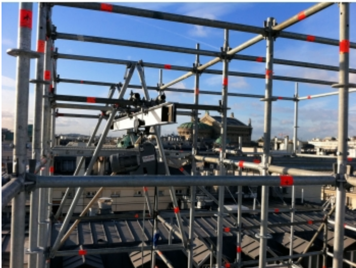
Installation sur fer fixée sur échafaudage
