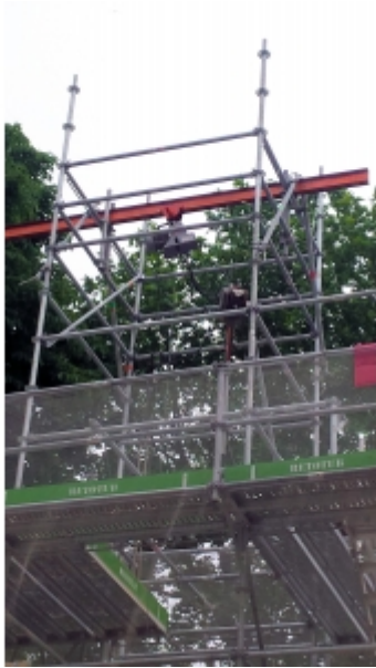
Installation sur fer fixée sur échafaudage
