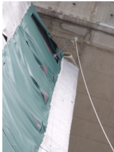
Potence installée sur un échafaudage baché
