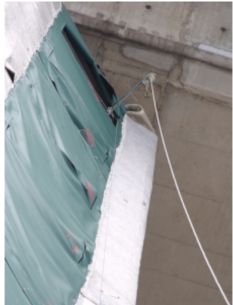
Potence installée sur un échafaudage baché
