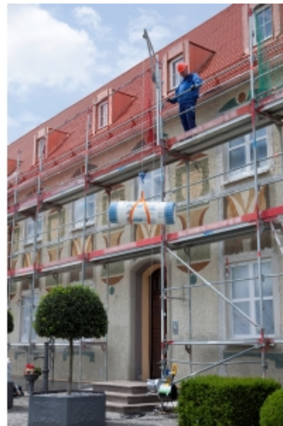
Installation sur échafaudage avec la potence au sommet
