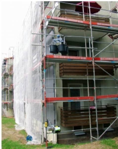
Installation sur échafaudage avec la potence au sommet
