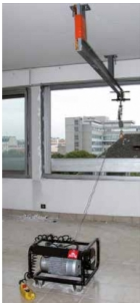
Installation avec une poulie de renvoi sur fer
