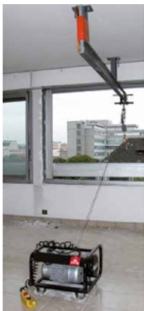
Installation avec poulie de renvoi sur fer
