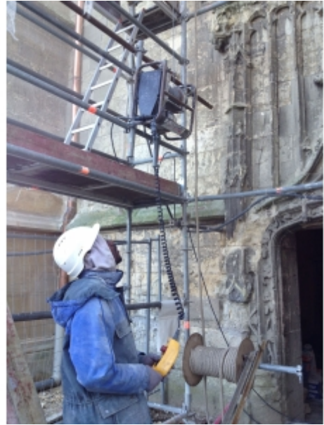
Fixation sur échafaudage
