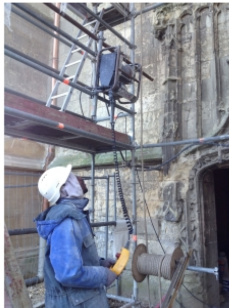
Fixation sur échafaudage
