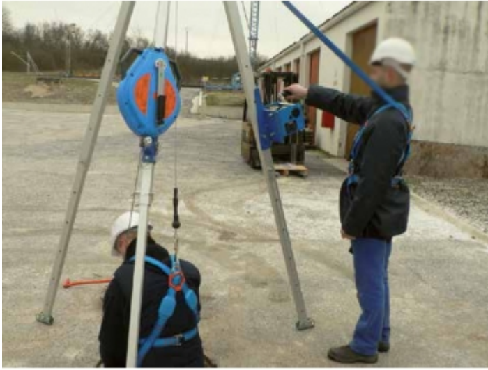
Levage de personne en travaux souterrains
