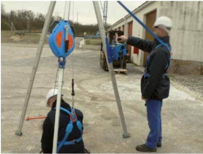
Levage de personne en travaux souterrains
