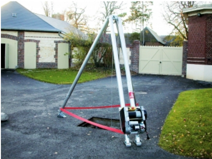
Travaux de réseau
