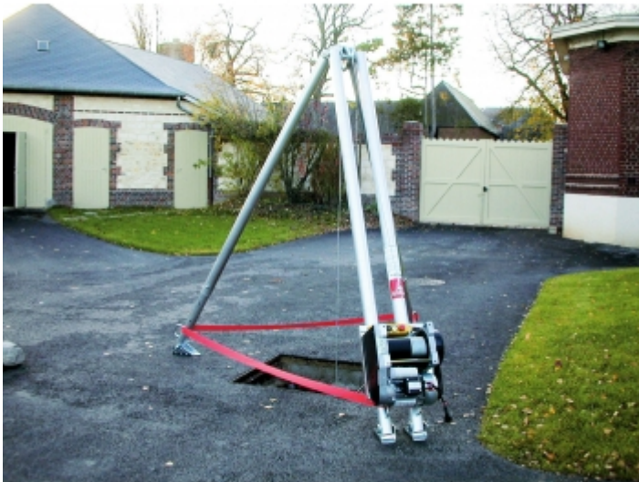
Travaux de réseau
