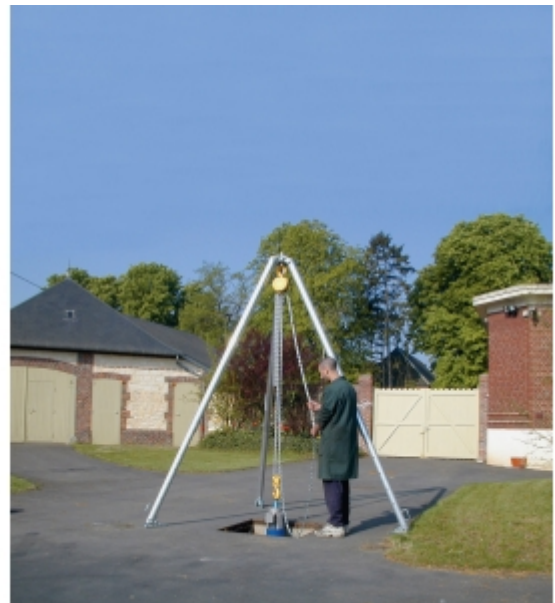
Travaux de réseau
