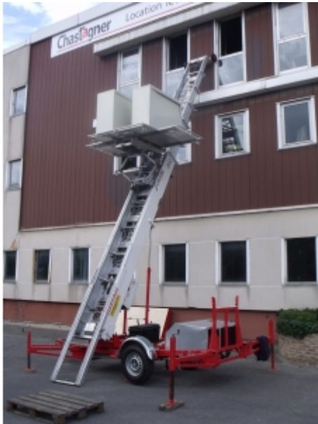
Installation en extérieur : caisse ouverte
