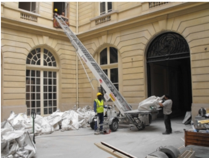
Installation en extérieur : caisse ouverte
