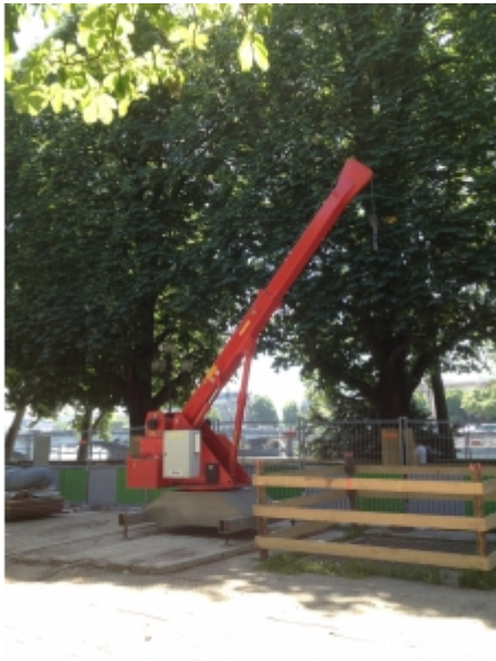
Travaux de réseaux
