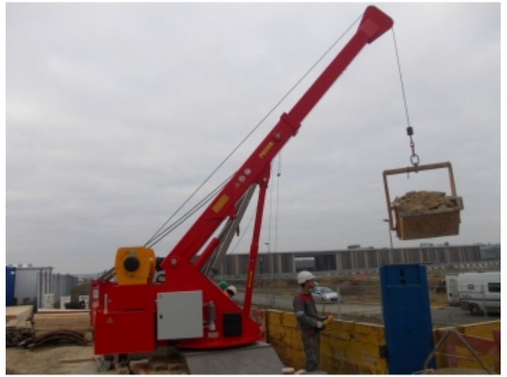
Travaux de réseaux
