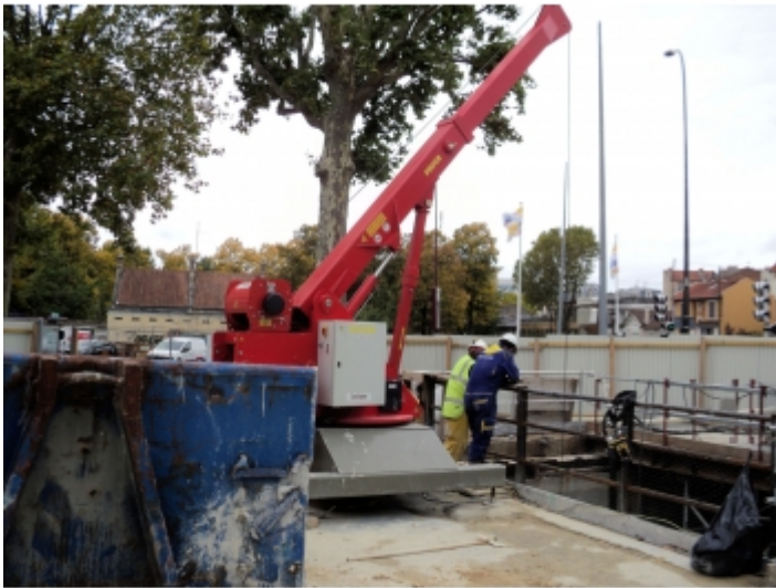
Travaux de réseaux
