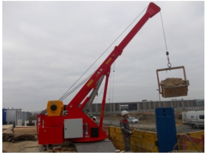
Travaux de réseaux
