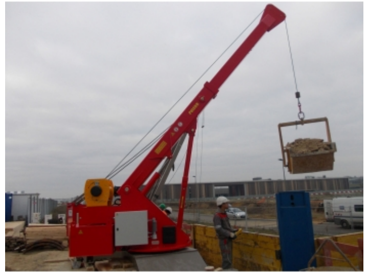
Travaux de réseaux
