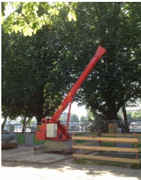
Travaux de réseaux
