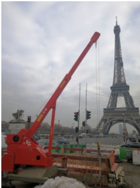
Travaux de réseaux
