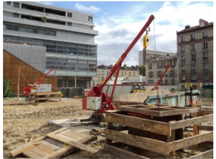
Travaux de réseaux
