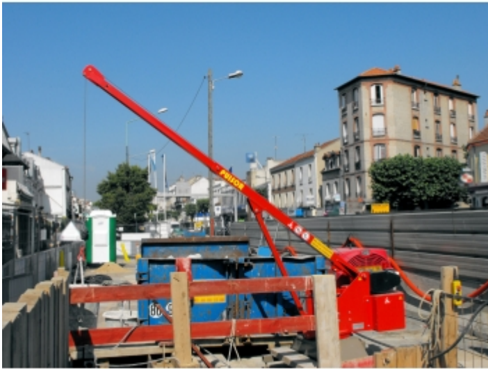
Travaux de réseaux
