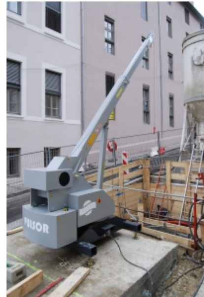
Travaux de réseaux
