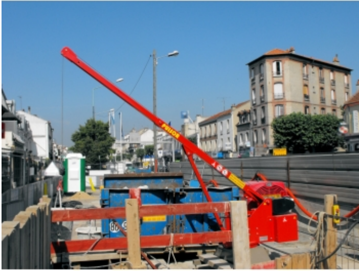
Travaux de réseaux
