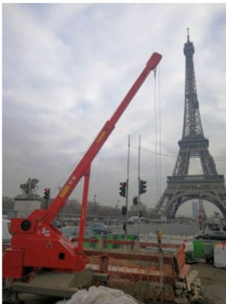
Travaux de réseaux
