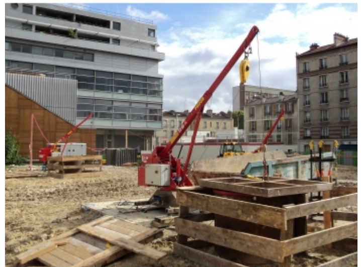
Travaux de réseaux
