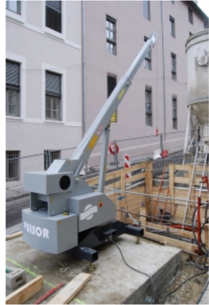
Travaux de réseaux
