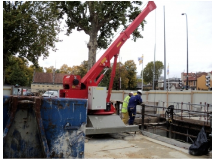
Travaux de réseaux
