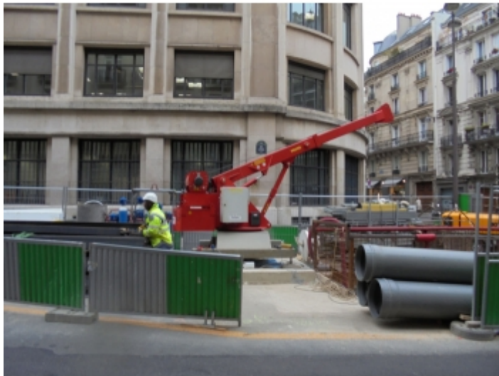
Travaux de réseaux
