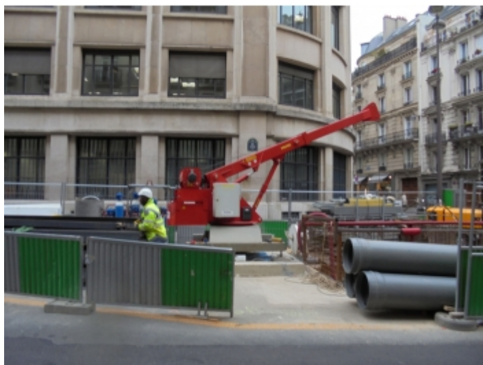
Travaux de réseaux
