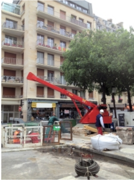
Travaux de réseaux
