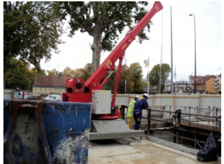
Travaux de réseaux
