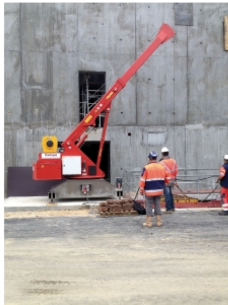
Travaux de réseaux
