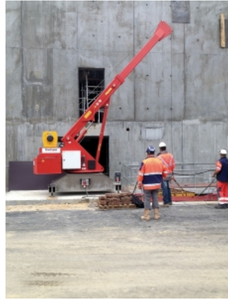
Travaux de réseaux
