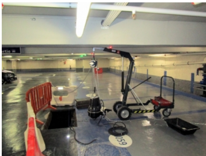
Levage de charges en réseaux souterrains
