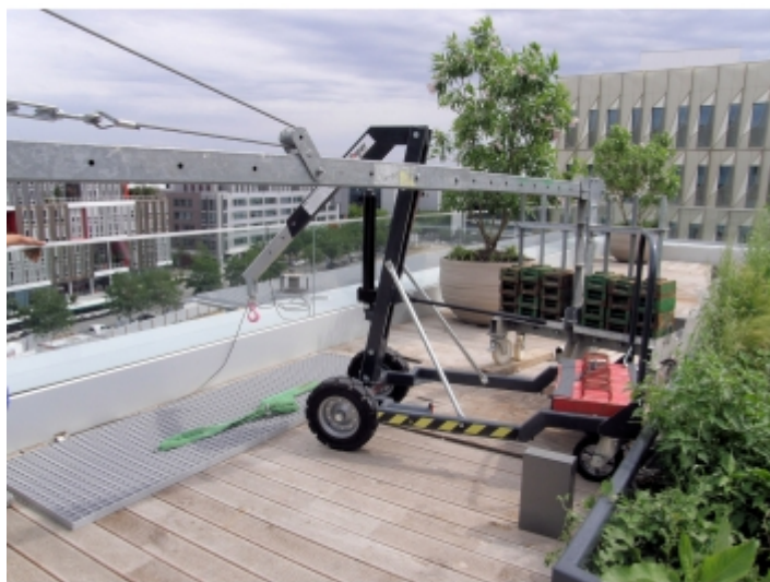
Levage d'une plaque grillagée
