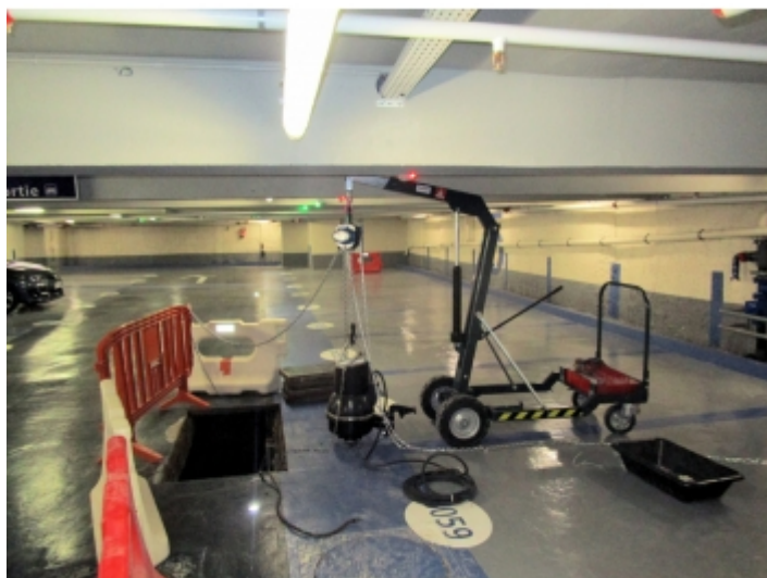
Levage de charges en réseaux souterrains
