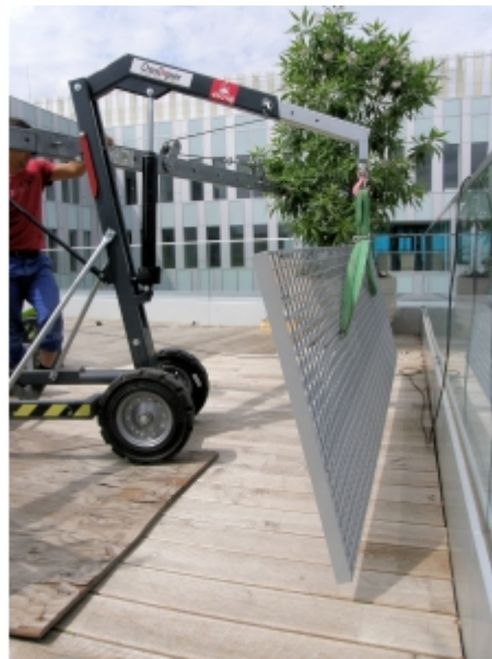
Levage d'une plaque grillagée
