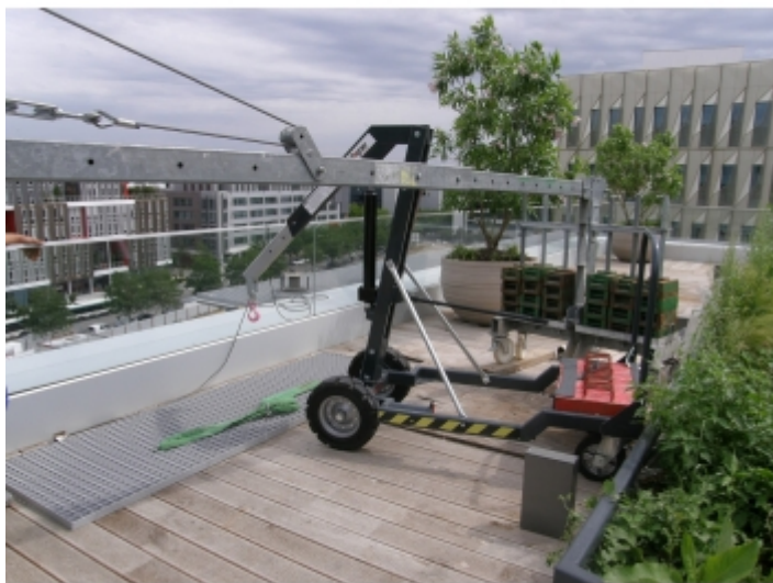
Levage d'une plaque grillagée
