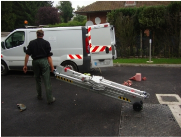
Travaux de maintenance sur une pompe à l'aide d'un portique
