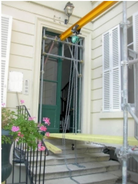
Installation sur fer avec un chariot manuel
