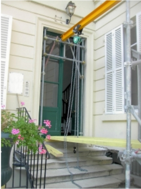
Installation sur fer avec un chariot manuel
