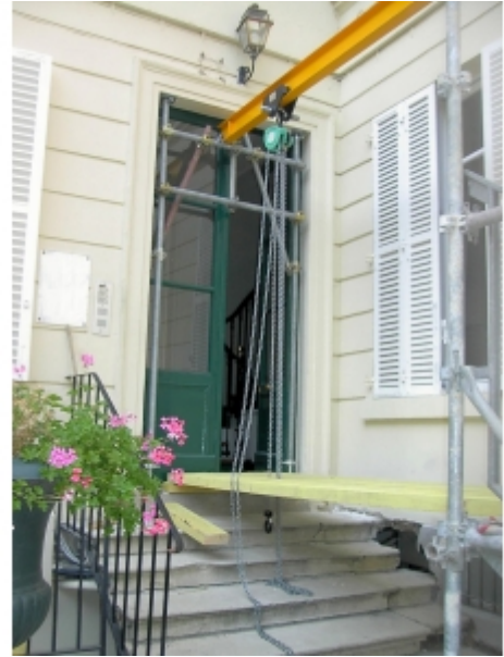
Installation sur fer avec un chariot manuel
