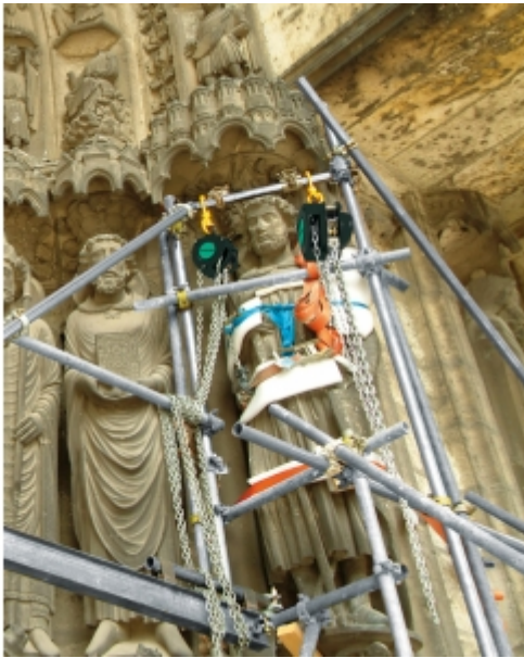
Installation sur échafaudage
