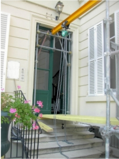
Installation sur fer avec un chariot manuel
