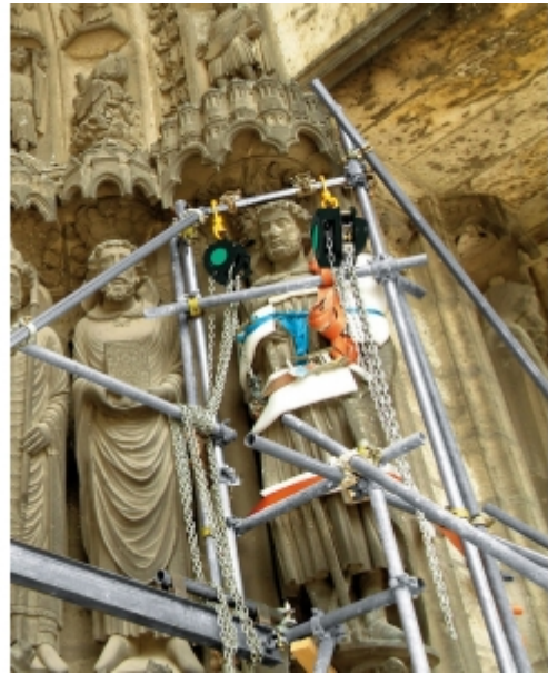
Installation sur échafaudage
