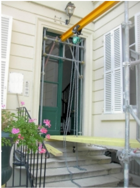
Installation sur fer avec un chariot manuel
