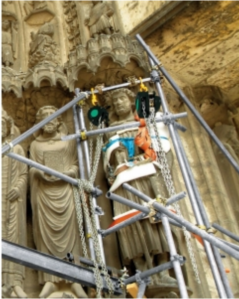
Installation sur échafaudage
