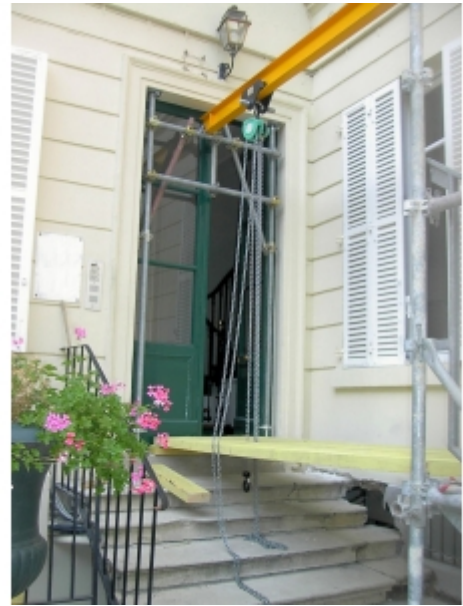
Installation sur fer avec un chariot manuel
