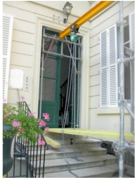
Installation sur fer avec un chariot manuel
