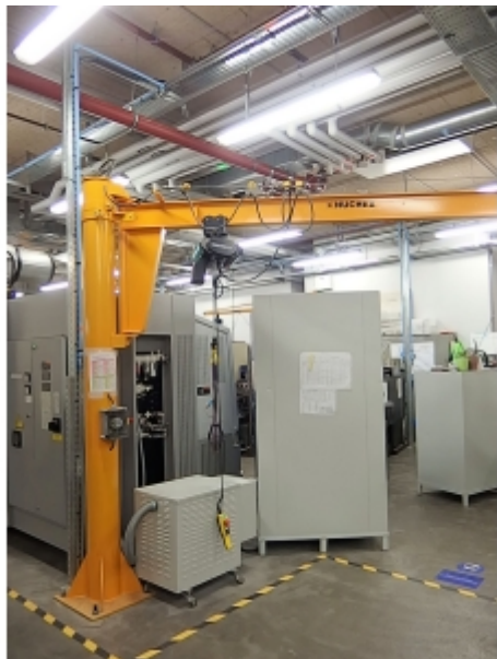
Installation sur portique avec un chariot manuel
