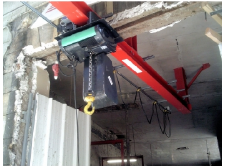
Installation sur fer
