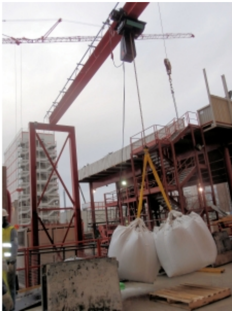
Installation sur fer
