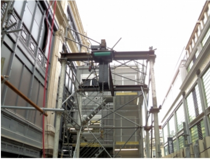
Installation sur fer
