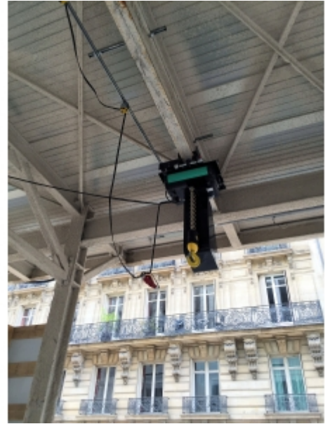
Installation sur fer
