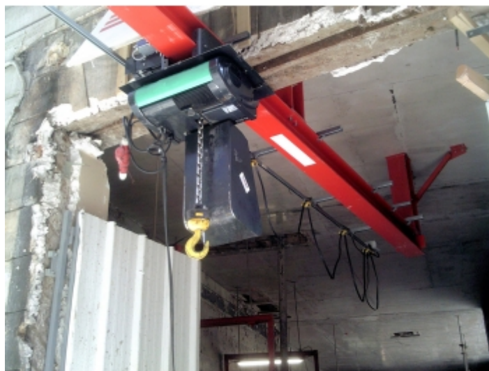
Installation sur fer
