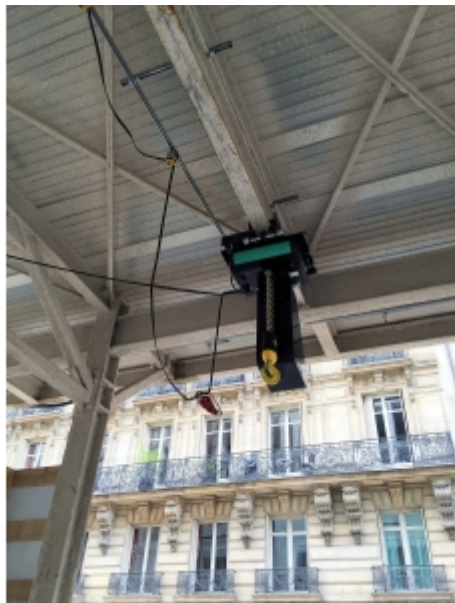
Installation sur fer
