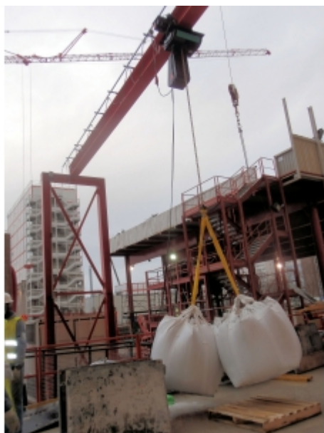
Installation sur fer
