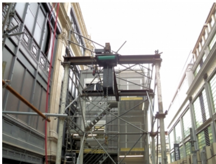
Installation sur fer
