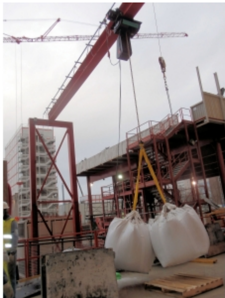
Installation sur fer
