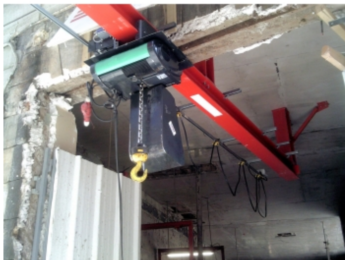
Installation sur fer
