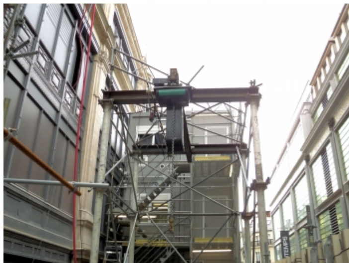
Installation sur fer
