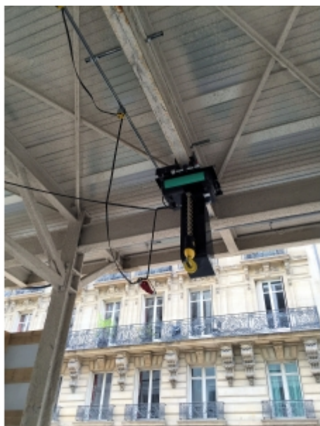
Installation sur fer
