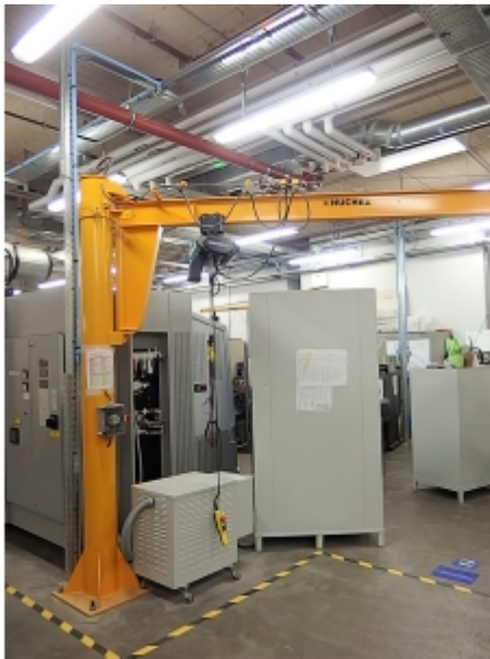
Installation sur portique avec un chariot manuel
