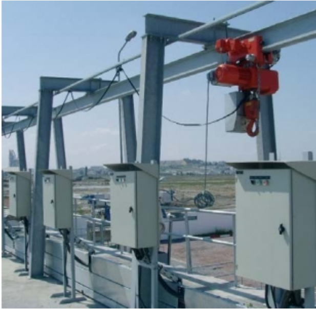
Installation sur fer
