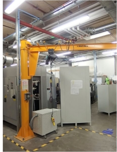
Installation sur portique avec un chariot manuel
