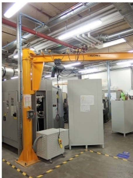
Installation sur portique avec un chariot manuel
