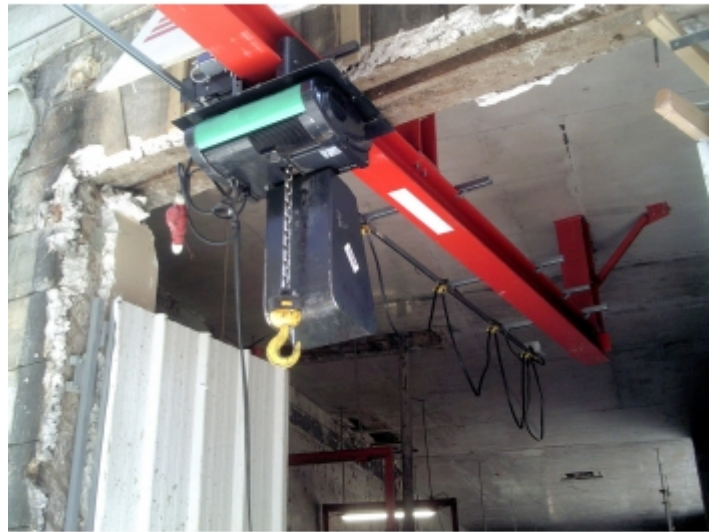
Installation sur fer
