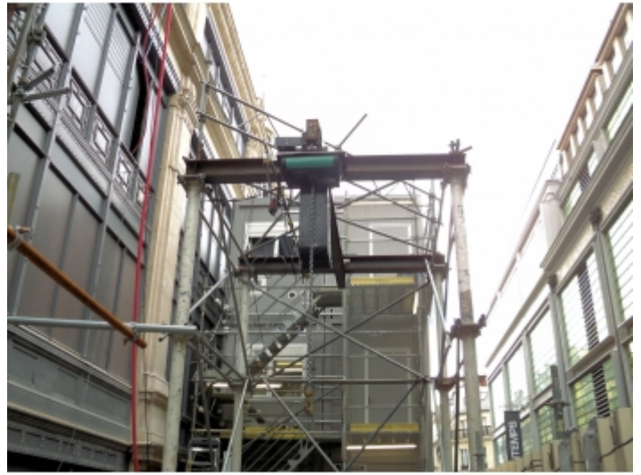
Installation sur fer
