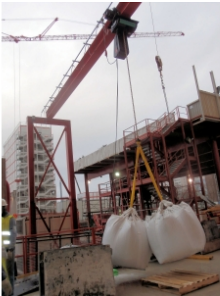
Installation sur fer
