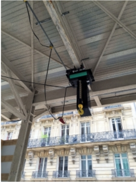
Installation sur fer
