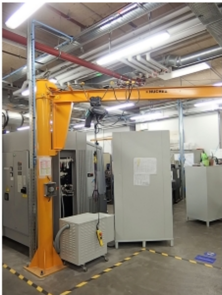
Installation sur portique avec un chariot manuel
