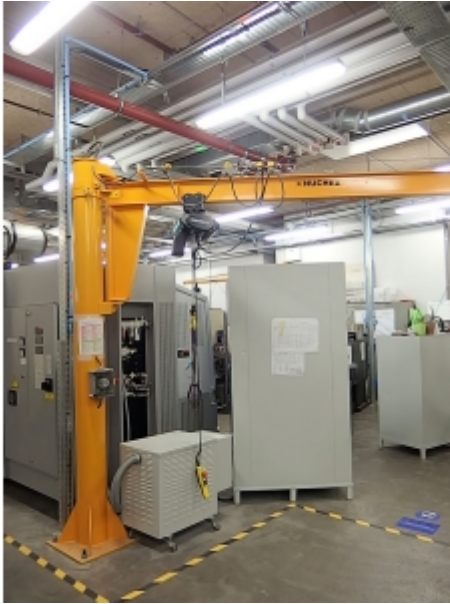
Installation sur portique avec un chariot manuel
